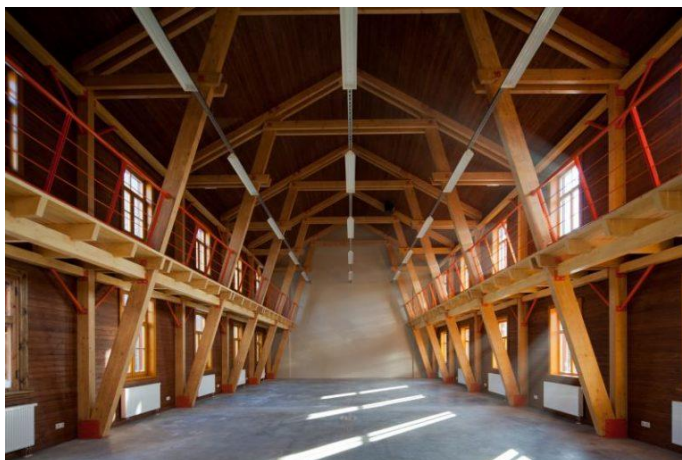
Fig. 6.19. Public wooden building with wood construction elements (Koka ēku renovācijas centrs "Koka Rīga", 2017).
