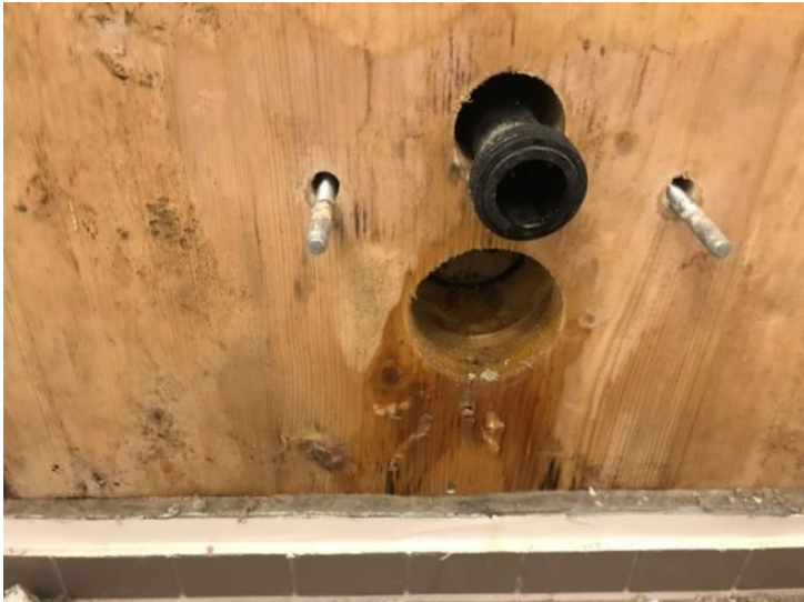
Fig. 3.52. Leaks (Byggeskadefonden, 2020).
